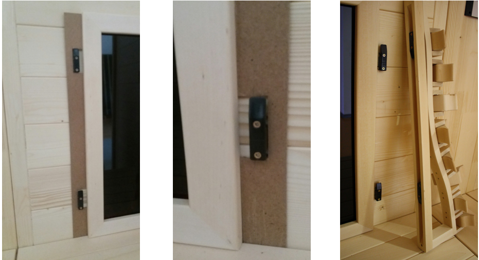
Abb. 49: Montage Rückenlehnen
