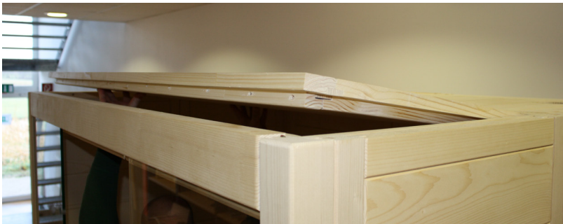
Abb. 18: Einlegen Dachelemente vorne
