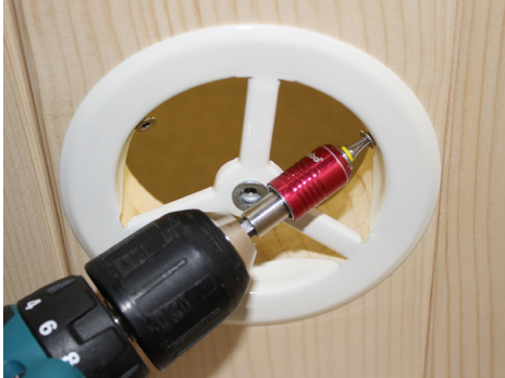
Fig. 35: Montaggio della ventilazione
