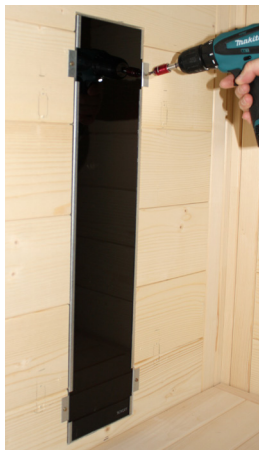
Fig. 38: Montar o radiador traseiro (radiador de infravermelhos ECO 350)
