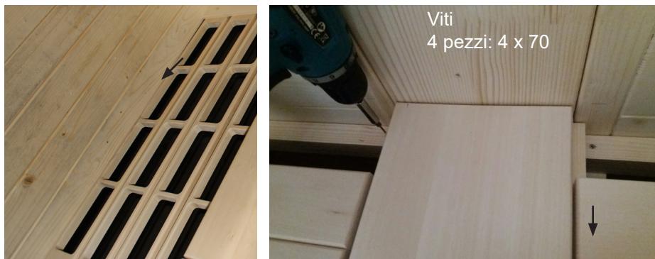
Fig. 46: Fissaggio della panca
