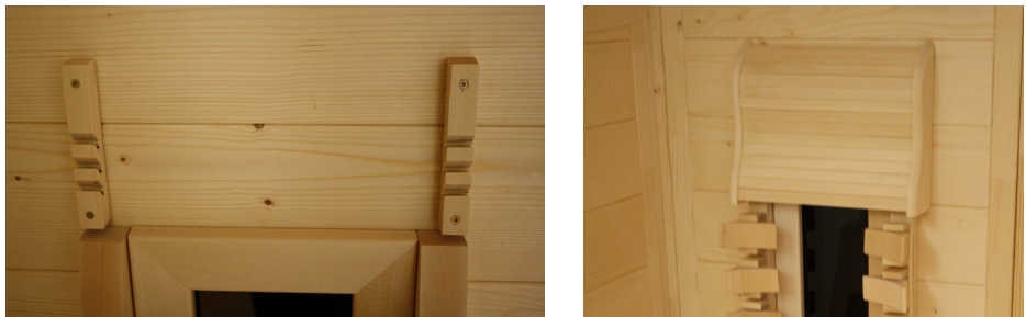
Fig. 49: Montagem dos apoios de cabeça
