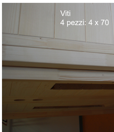
Fig. 47: Montaggio dei listelli distanziatori sul pannello posteriore
