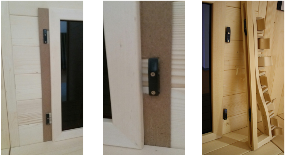
Fig. 50: Montagem dos encostos
