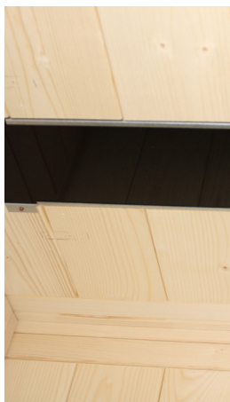
Fig. 37: Montaggio degli irradiatori posteriori (irradiatore a infrarossi ECO 350)
