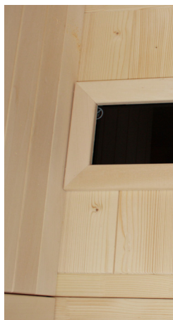
Fig. 38: Montaggio della mascherina degli irradiator posteriori
