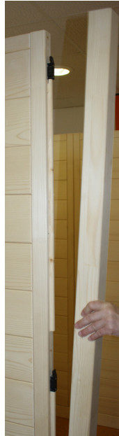
Afb. 9: Montage van de twee voorste hoekstaanders met groef voor glas
