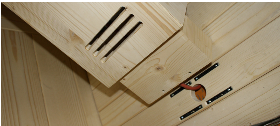
Fig. 28: Fissaggio degli irradiatori anteriori
