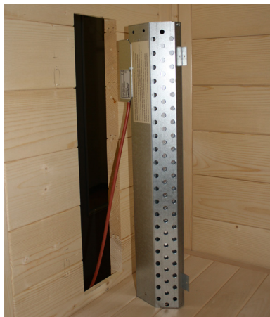
Fig. 37 : Monter le radiateur arrière (radiateur infrarouge ECO 350)
