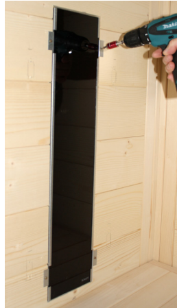
Abb. 37: Rückenstrahler (Infrarot-Strahler ECO 350) montieren
