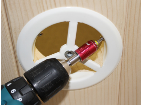
Fig. 35 : Montage de la ventilation
