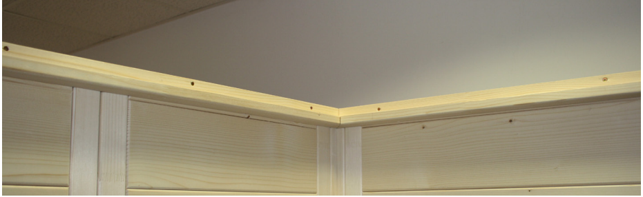
Fig. 17: Inserção do elemento de teto traseiro com abertura de ventilação
