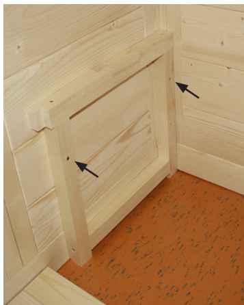
Fig. 31: Montaggio del supporto della panca
