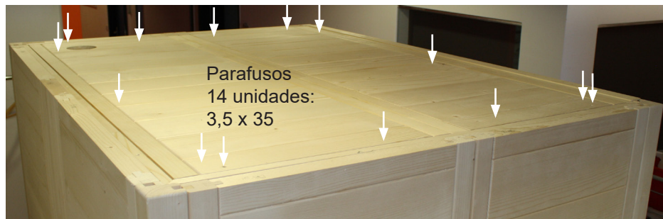
Fig. 19: Fixação dos elementos de teto
