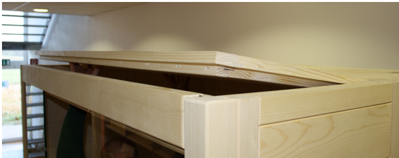
Fig. 18 : Insertion de l'élément de toit avant
