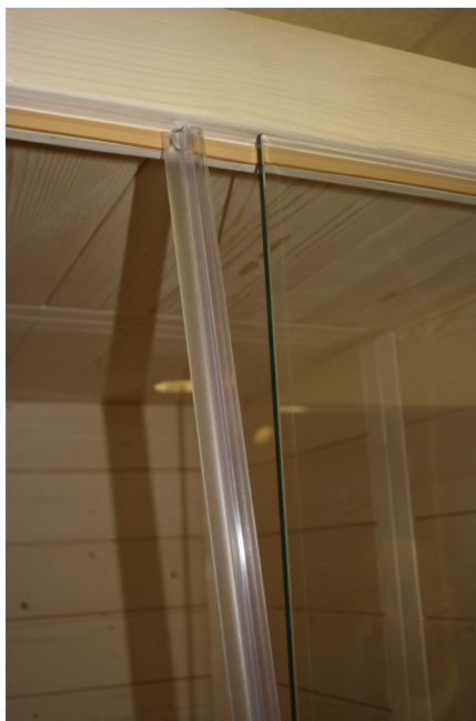
Fig. 20 : Positionnement du joint de la porte
