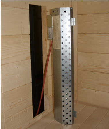
Abb. 37: Rückenstrahler (Infrarot-Strahler ECO 350) montieren
