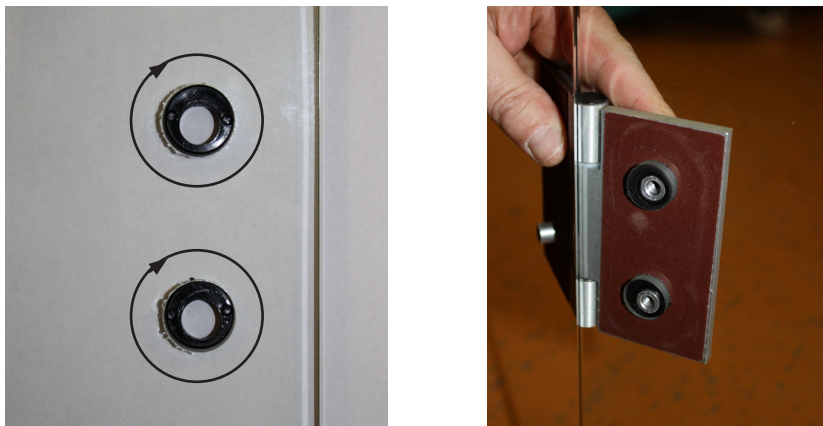
Fig. 22: Montagem das ferragens da porta 1
