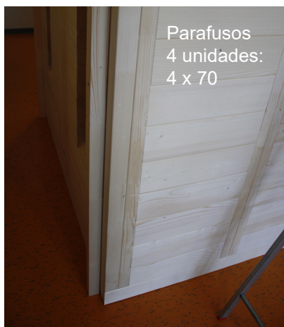
Fig. 48: Montagem das barras distanciadoras na parede traseira
