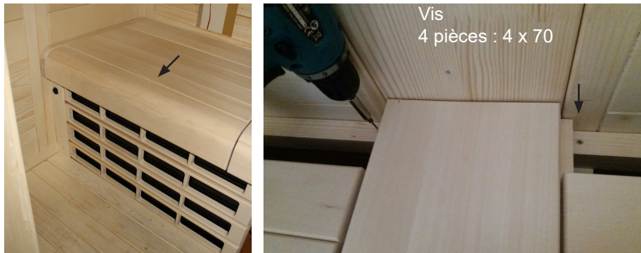
Fig. 46 : Fixation du banc
