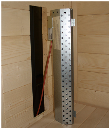
Fig. 38: Montar o radiador traseiro (radiador de infravermelhos ECO 350)
