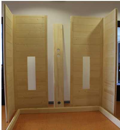
Fig. 5: Montagem na armação do chão
