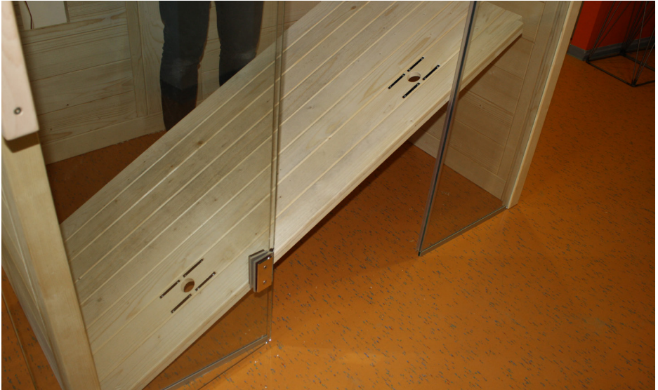
Fig. 27 : Poser le plancher de la cabine
