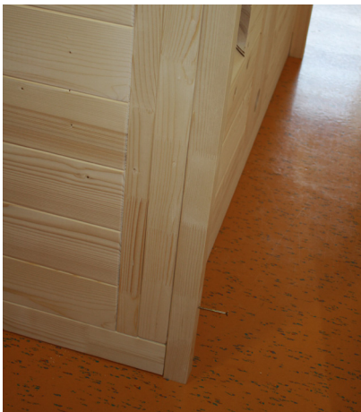
Abb. 47: Montage Abstandleisten Rückwand
