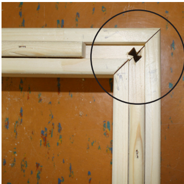
Abb. 2: Bodenelemente verbinden
