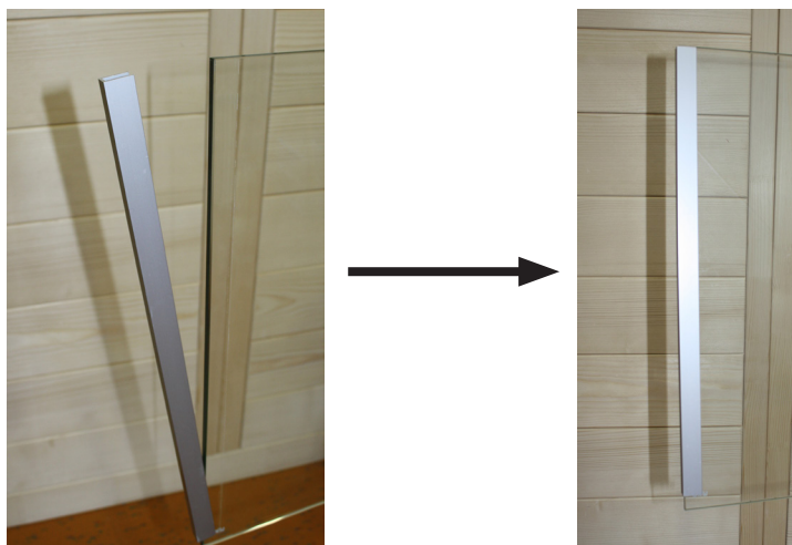
Fig. 11: Applicazione dei profili a U sui pannelli in vetro
