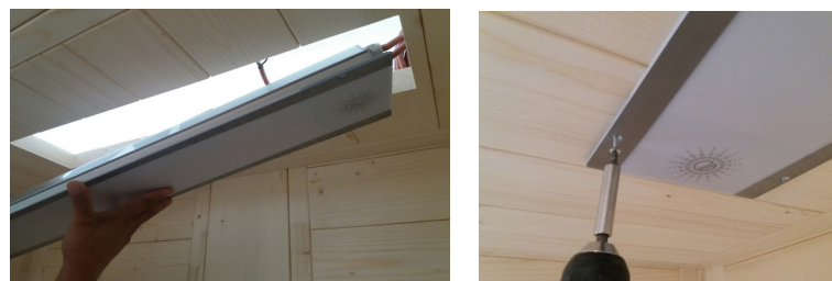
Fig. 45 : Montage lampe couleur
