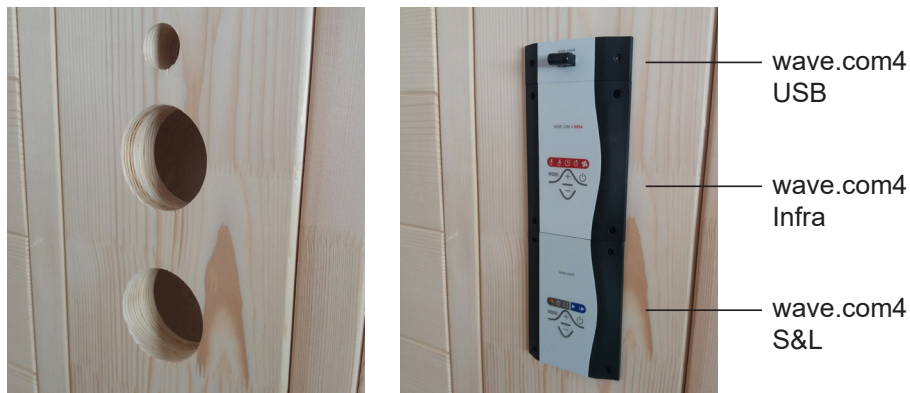
Fig. 44: Montaggio dell'unità di comando
