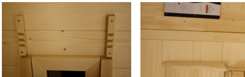
Fig. 48: Montaggio dei poggiatesta
