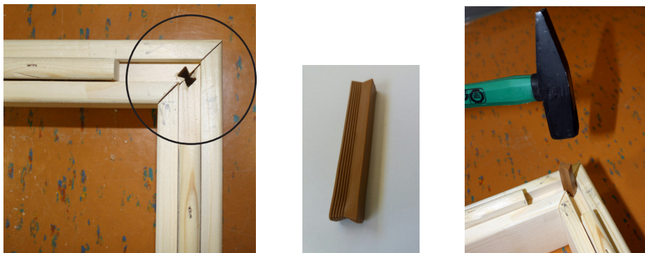
Fig. 2: Unir os elementos do chão
