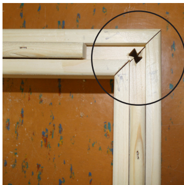
Fig. 2 : Raccorder les éléments du plancher
