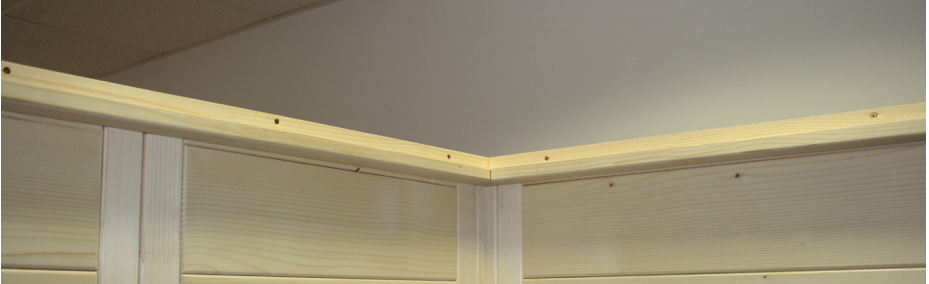
Afb. 17: Plaatsen van dakelement achter met ventilatoruitsparing
