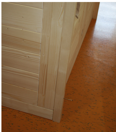
Fig. 48: Montagem das barras distanciadoras na parede traseira
