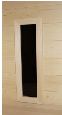
Abb. 38: Blende der Rückenstrahler montieren
