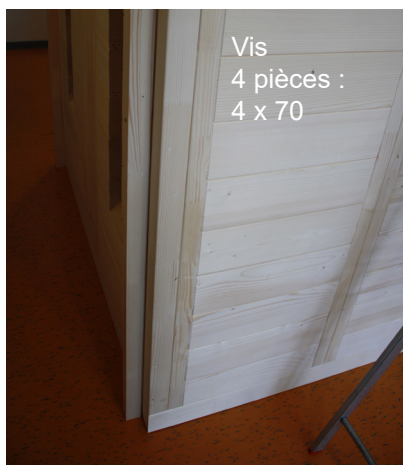
Fig. 47 : Montage des barres d'écartement paroi arrière
