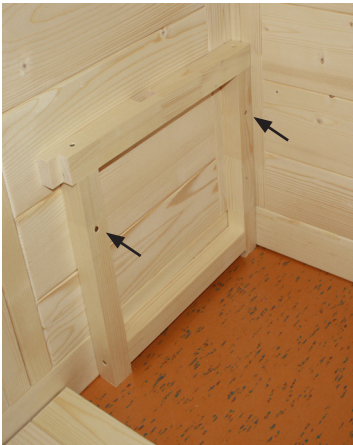
Fig. 32: Montagem do apoio do banco
