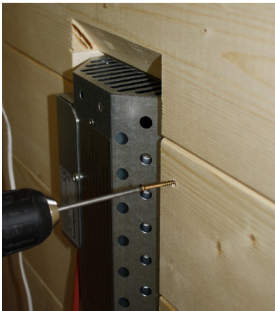
Abb. 38: Blende der Rückenstrahler montieren
