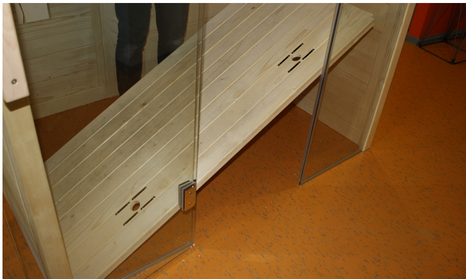
Fig. 27: Inserimento del pavimento della cabina
