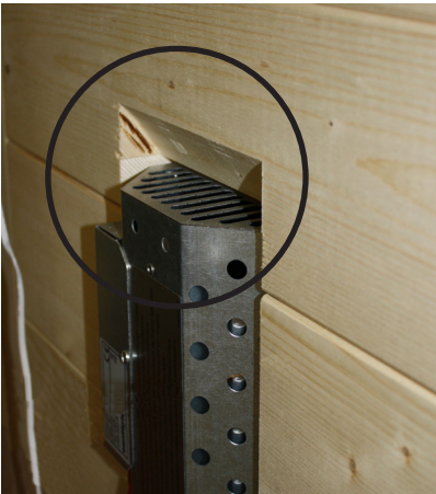
Kuva 1: Tuuletusraot vapaina
