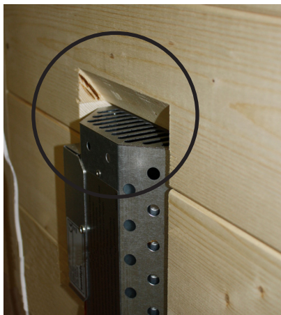
Fig. 1: Lasciare libere le fessure di ventilazione
