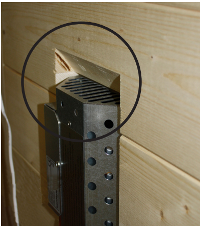
Afb. 1: Ventilatiesleuven vrij laten
