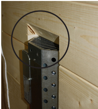
Fig. 1 : Ne pas couvrir les fentes d'aération
