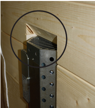
Abb. 1: Lüftungsschlitze freilassen
