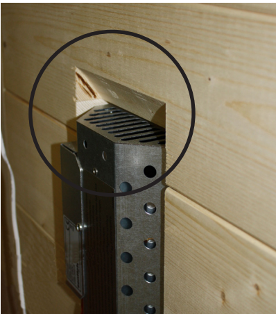
Bild 1: Ventilationsöppningarna ska lämnas öppnade.
