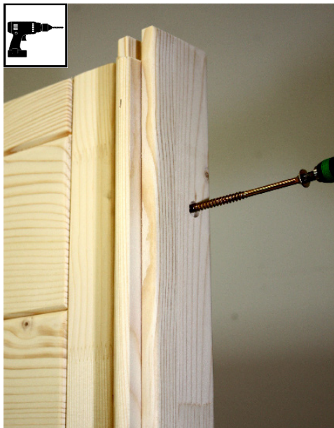
8 vis 6 x 120 mm par montant d'angle
