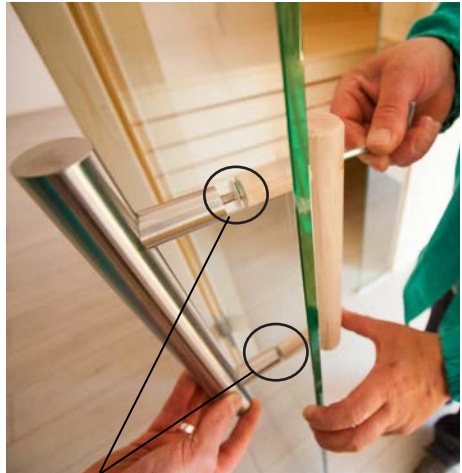
Pose des rondelles de calage en plastique pour poignée inox
