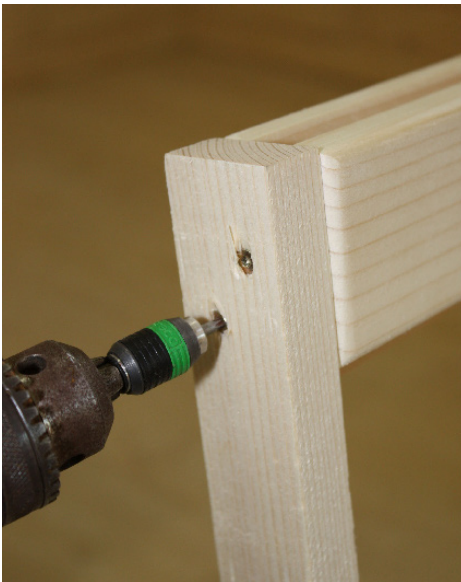
Transportleiste vom Türstock entfernen
