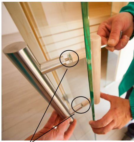
Applicare rondelle di plastica nelle maniglie Nirosta
