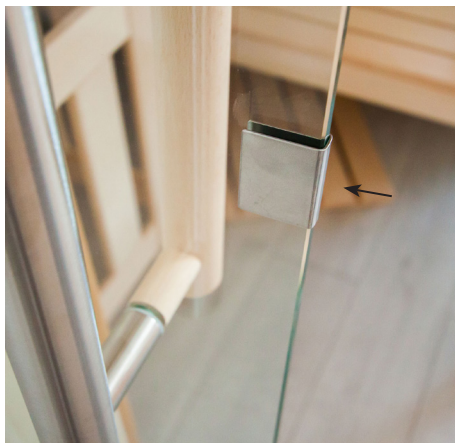
Applicare rondelle di plastica nelle maniglie Nirosta
