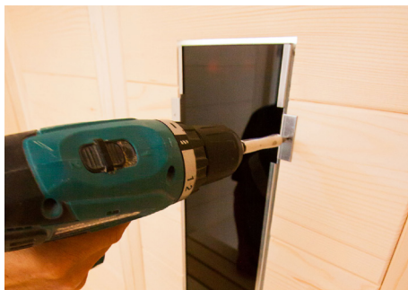
4 parafusos de 3 x 20 mm
