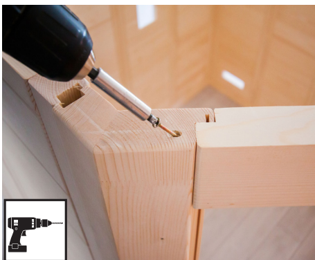
Broca de 3 mm, 1 parafuso de 4 x 70 mm
