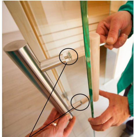
Kunststoff Beilagscheibe bei Niro-Griff beilegen
