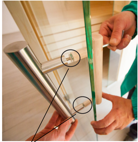
Kunststoff Beilagscheibe bei Niro-Griff beilegen
