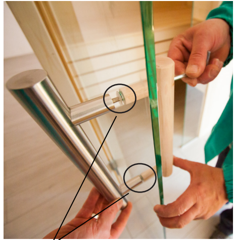
Applicare rondelle di plastica nelle maniglie Nirosta
