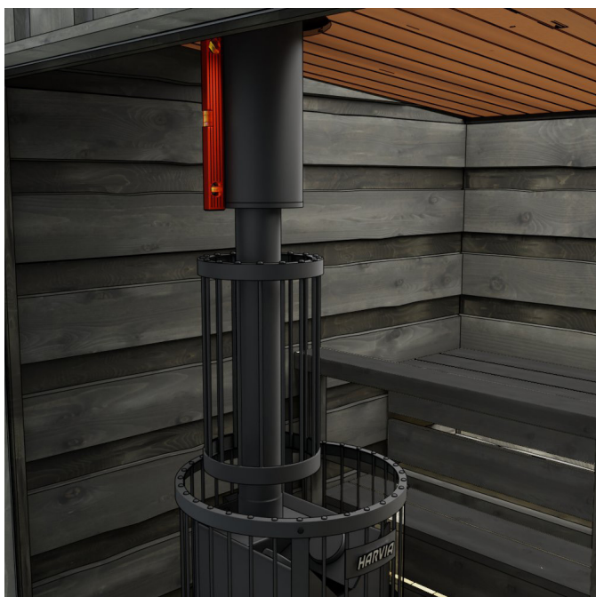
12. Vérifiez la rectitude de la cheminée. Déplacez le poêle si nécessaire.
